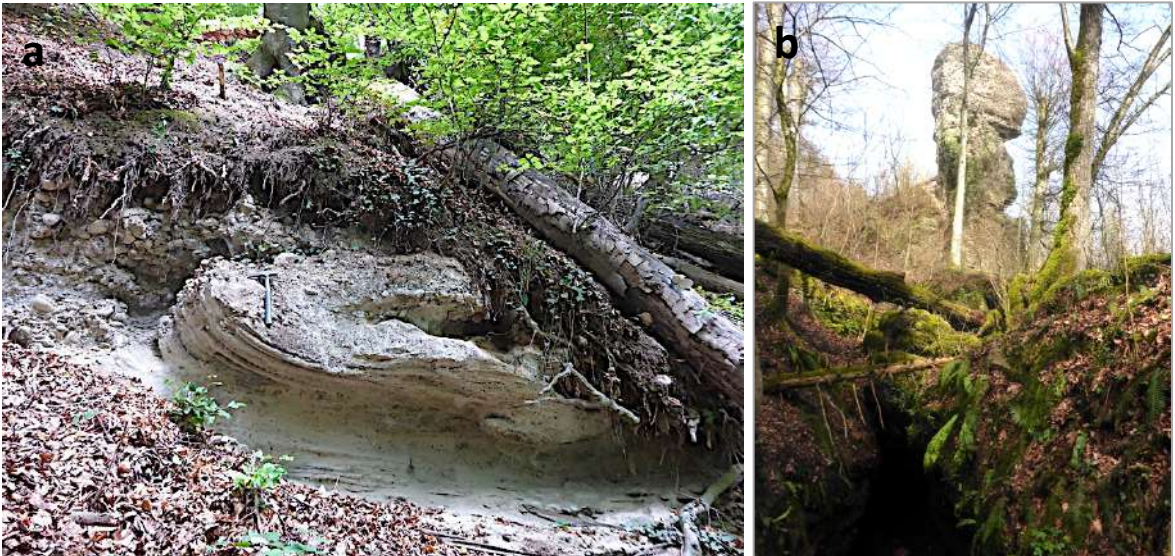
Abbildung A 41 a: Links: Mysteriös verfaltetes Sedimentpaket im Tieferen Deckenschotter des Bruggerbergs (glaziale Deformation? Koo 47.49733/8.22138). Rechts: Versackte Türme von verkitteten Tieferen Deckenschottern im Tüfels-Chäller (Baregg bei Baden, Koo 47.46318/8.30142), Photos: A. Lambert, Baden (Wildi & Lambert 2019).
