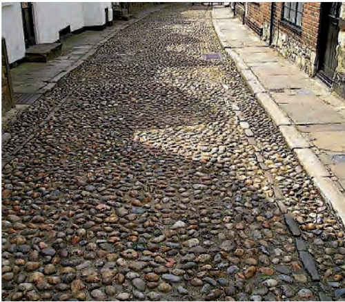
So wie in diesem Dorf in England könnten die Strassen Berns im 15. Jh. ausgesehen haben. Der Belag besteht aus gerundeten Flussgeröllen.
