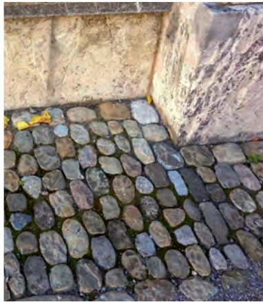
Im Innenhof des Burgerspitals ist ein Belag aus halbierten Flussgeröllen (Hälblingen) erhalten geblieben.
